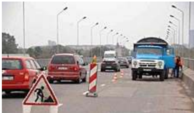
Tilto per Danės upę Mokyklos g. ir viaduko Liepų g. rekonstrukcija
